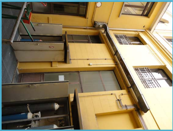
VISTA DEL CANALE POSACAVI IN ACCIAIO ESISTENTE NEL CAVEDIO
